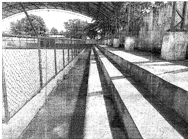
Visão Geral - quadra e arquibancada
