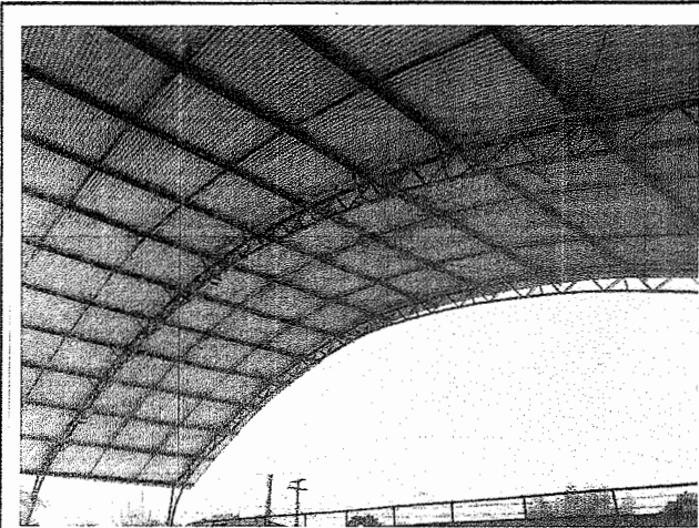
Visão Geral da Coberta
