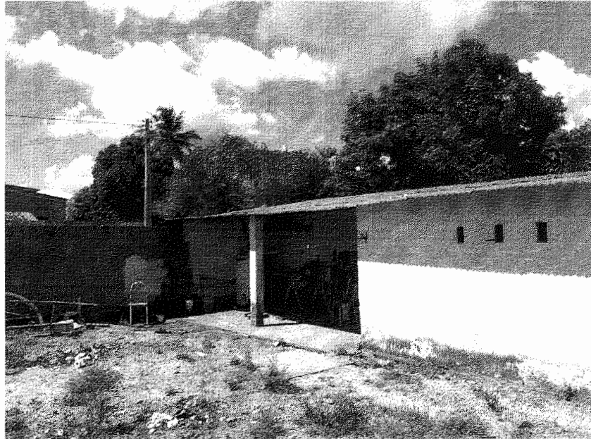
Figura 04 – Escritório do Canteiro de Obras
