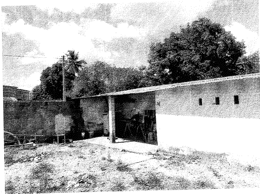
Figura 04 – Escritório do Canteiro de Obras
