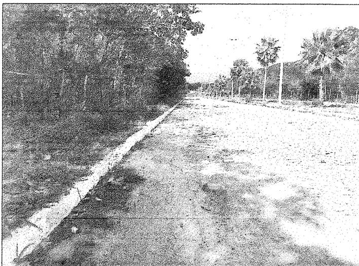
Na imagem 7, ainda mostrou a ciclovía na via da direita aproximadamente na estaca 0+260,00, com o lastro de concreto totalmente desgastado. Também pôde-se notar a presença de muita vegetação onde deveria ser o passeio.
