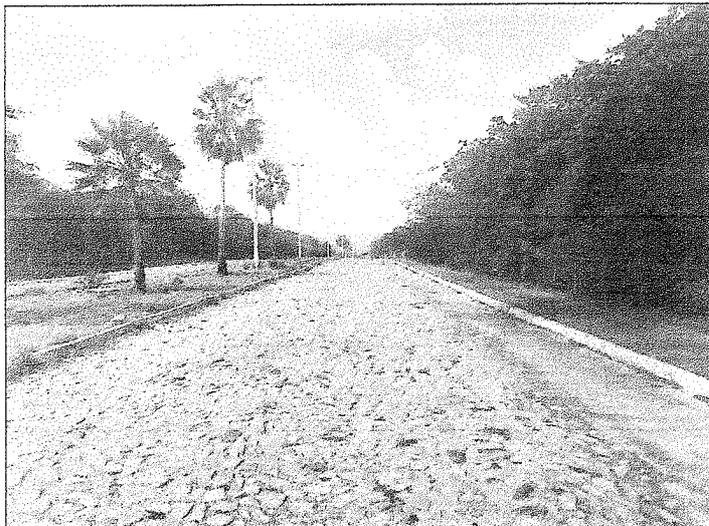
A imagem 14, mostra a via da lateral esquerda na estaca 0+350,00, onde foi possível notar que o pavimento se encontra em bom estado, na ciclovia o lastro de concreto também está em boas condições.
