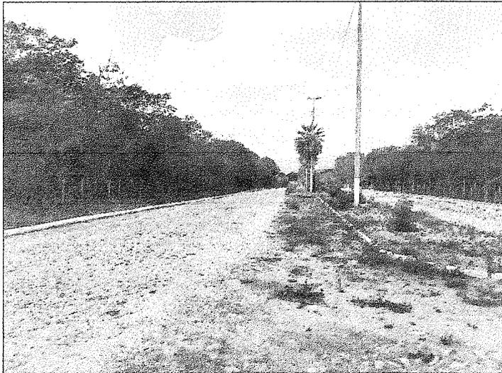
Na imagem 11, apresenta o recuo do retorno da via da direita, notou-se também a presença de vegetação na via e a inexistência de placas indicando retorno permitido.
