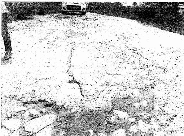
Figura 1: Revestimento a ser retirado
