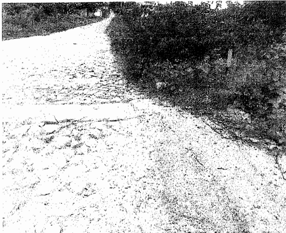
Figura 3: Chegada da via na saída da passagem
