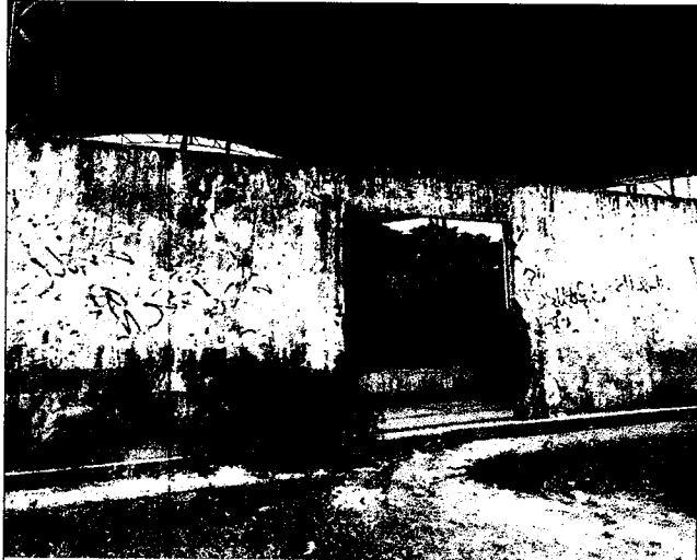
Acesso sem Portão e Pilar danificado
