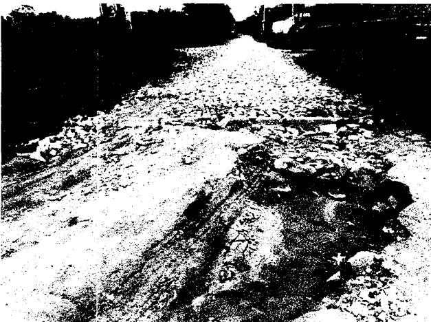
Av. Geraldo Batista: Trecho com pavimentação em Pedra Tosca a ser substituído.
