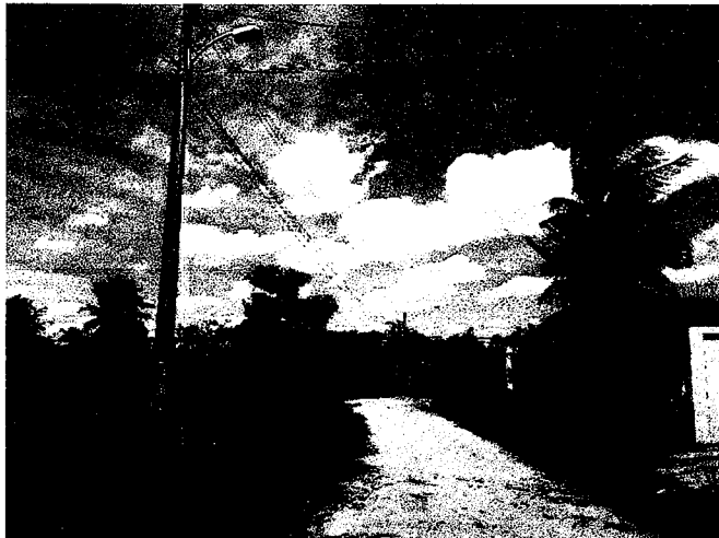
Rua P: Trecho sem pavimentação
