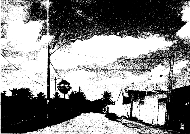
Rua P: Trecho com pavimentação totalmente danificada
