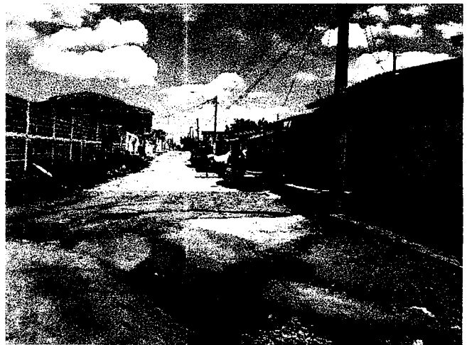
Rua P: Cruzamento Rua P com Rua F
