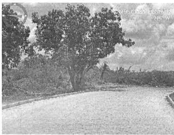
Visão geral da Rua Local F
