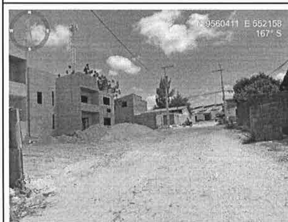
Visão geral da Rua dos Bulgaris
