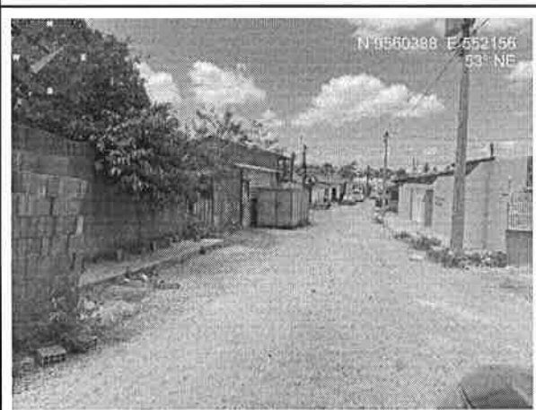
Visão inicial da Rua das Bulgaris
