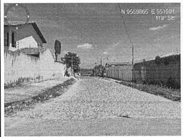
Visão inicial da Rua Nair Sátiro
