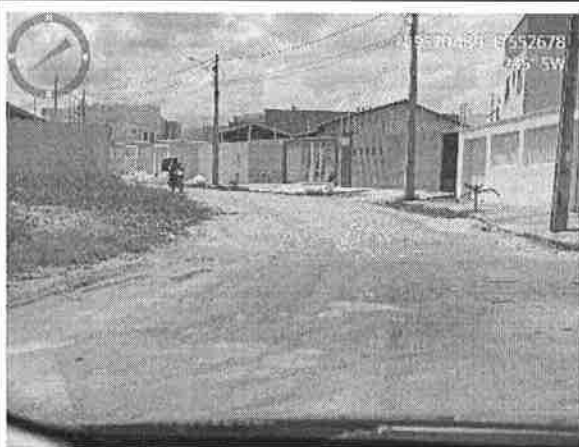
Visão geral da Rua Local F
