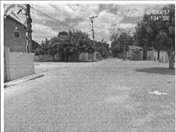
Visão geral da Rua Manoel Cavalcante
