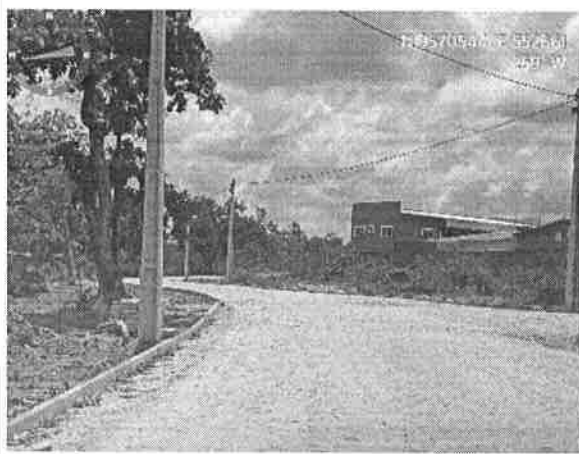
Visão geral da Rua Local F
