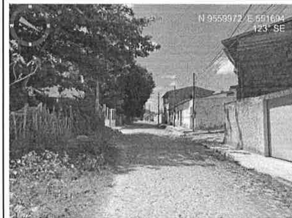
Visão geral da Rua José Maria de Castro
