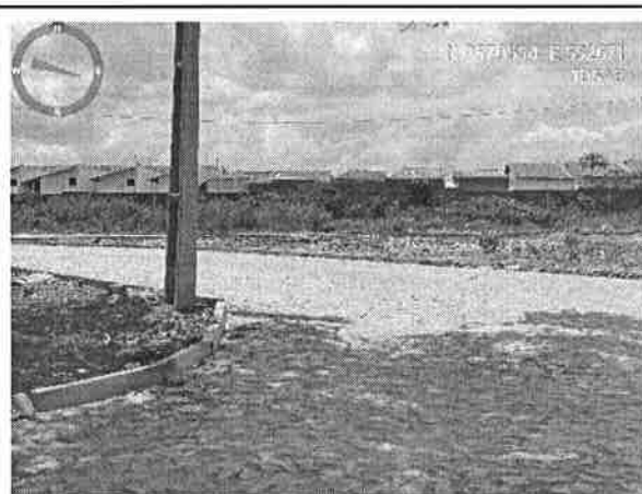
Visão geral da Rua Local F
