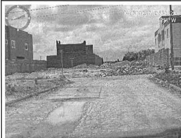
Visão geral da Rua Local F
