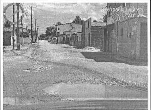
Visão geral da Rua São Francisco
