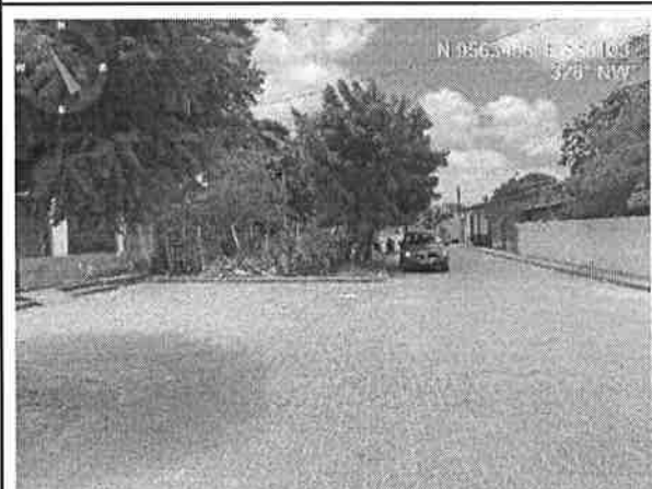
Visão geral da Rua Manoel Cavalcante
