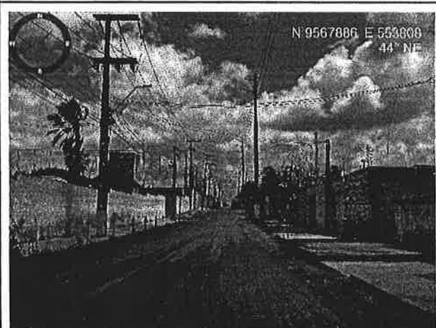
Visão final da Rua S
