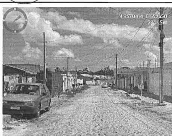
Visão geral da Rua Local A
