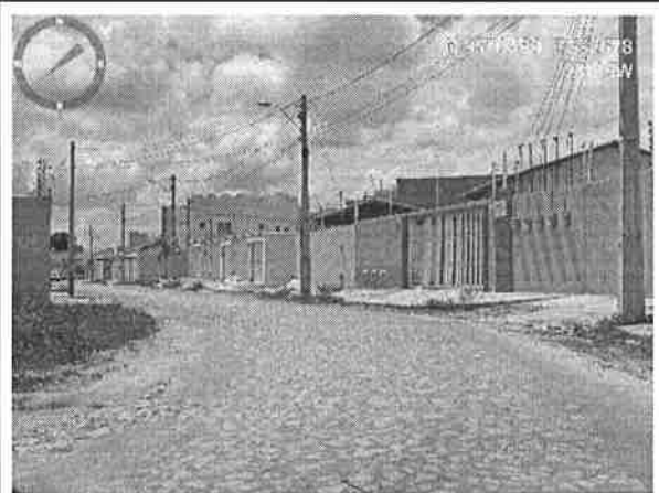
Visão geral da Rua Local F
