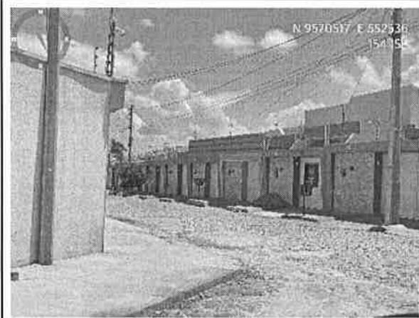
Visão geral da Rua Local A
