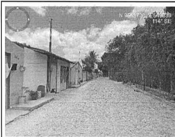
Visão geral da Rua Manoel Cavalcante
