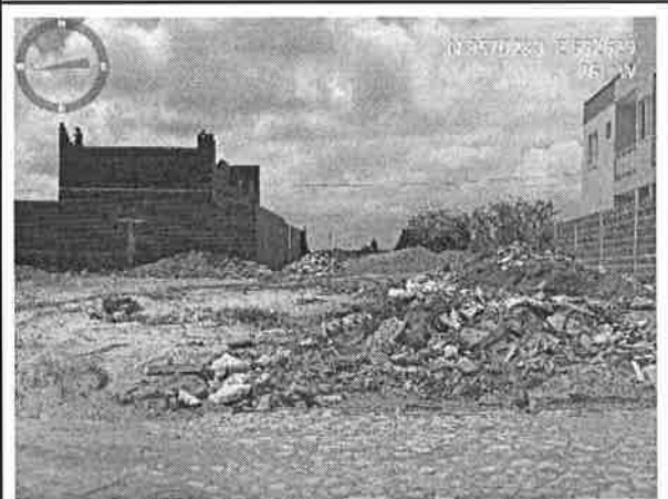
Visão geral da Rua Local F
