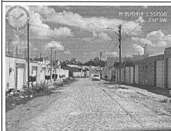
Visão geral da Rua Local A
