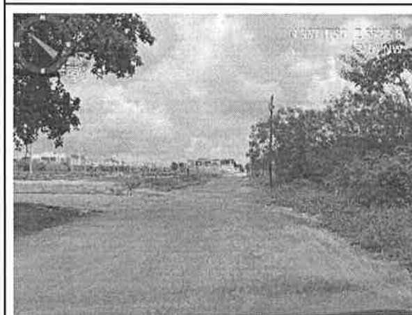
Visão geral da Rua Local F
