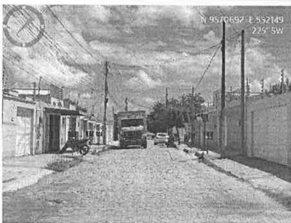
Visão geral da Rua São Francisco
