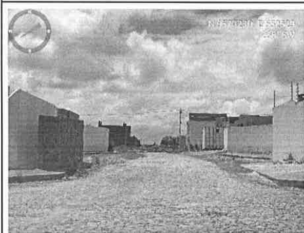
Visão geral da Rua Local F
