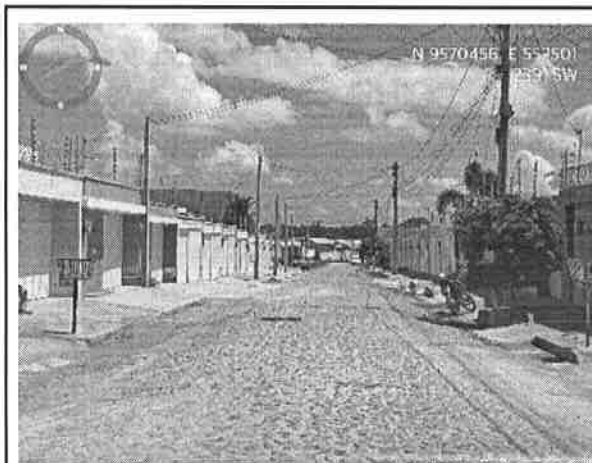
Visão geral da Rua Local A
