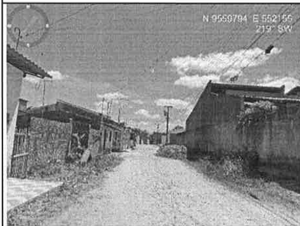
Visão inicial da Rua José Monteiro Filho
