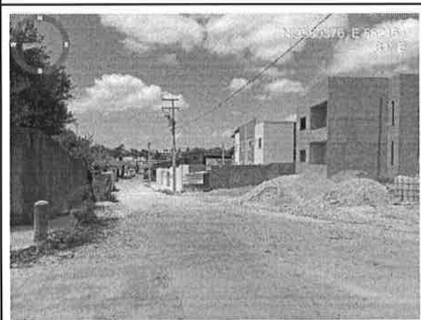
Visão geral da Rua dos Bulgaris
