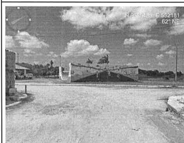
Visão geral da Rua dos Bulgaris
