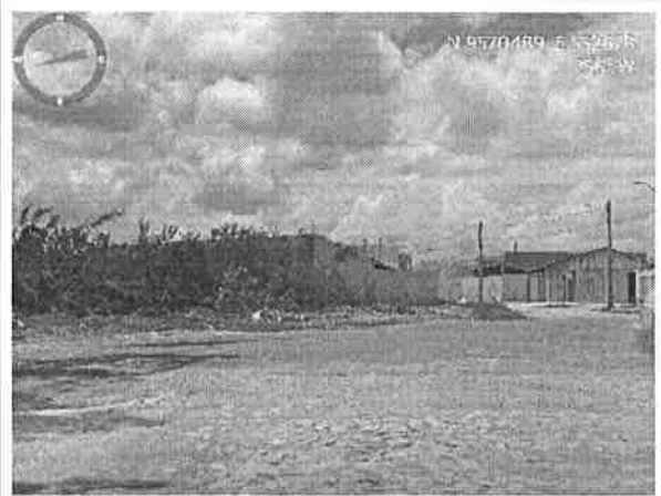
Visão geral da Rua Local F
