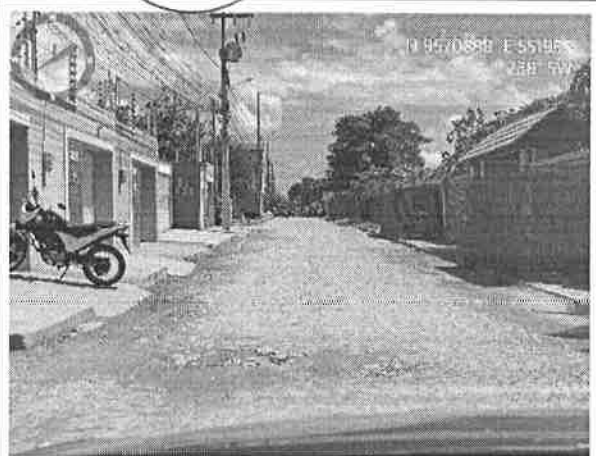
Visão geral da Rua São Francisco
