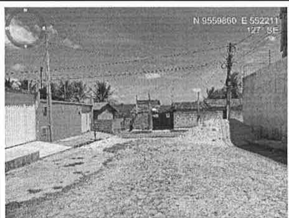
Visão final da Rua Manoel Sátiro
