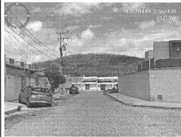
Visão inicial da Rua Local D
