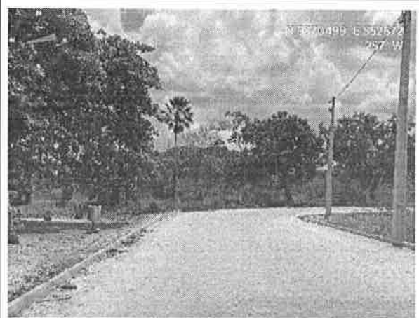
Visão geral da Rua Local F
