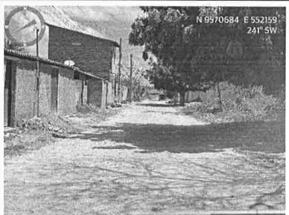
Visão geral da Rua São Francisco
