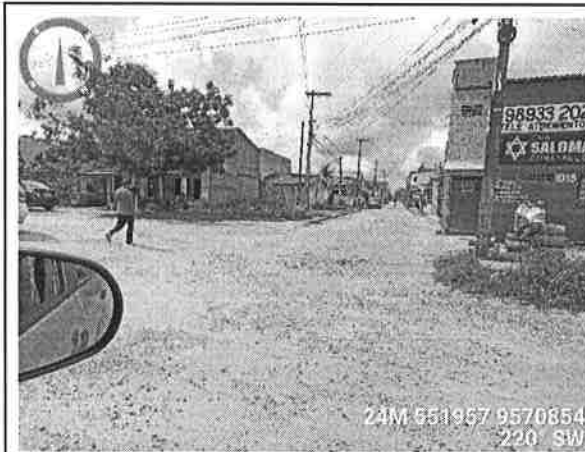
Av. ETA Gavião - Lado Esquerdo
