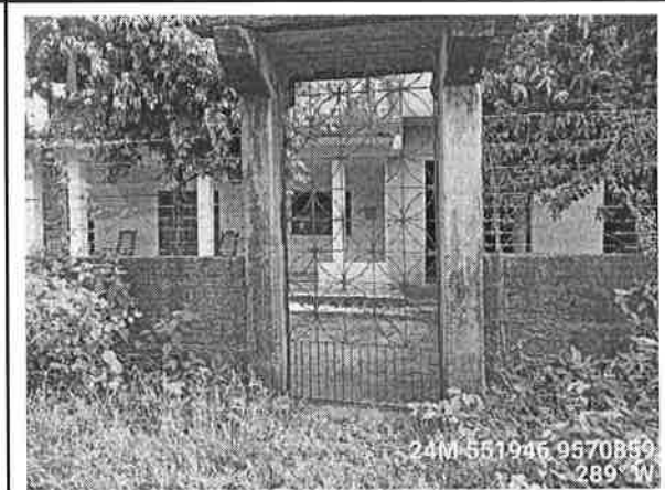
Av. ETA Gavião - Lado Direito
