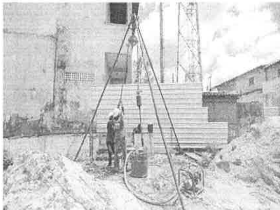
Foto 1 – Detalhe da operação de cravação do amostrador padrão para obtenção do "SPT" do terreno de fundação.
