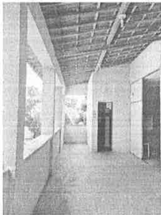
Área interna - Pavimento superior
