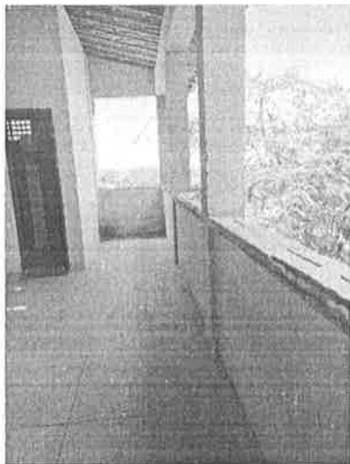
Parapeito - Pavimento superior
