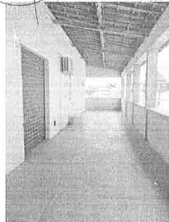
Área interna - Pavimento superior
