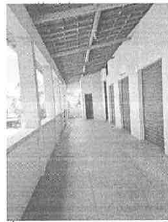
Área interna - Pavimento superior
