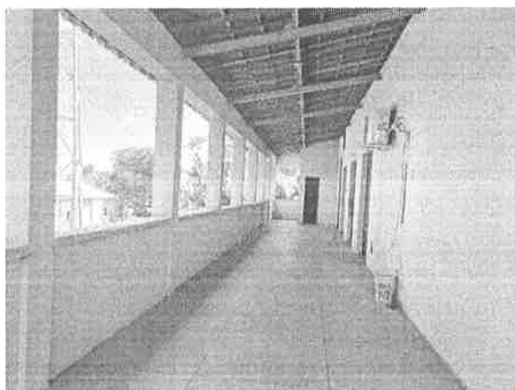
Área interna - Pavimento superior
