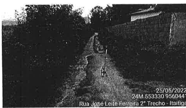
Vista geral do trecho
