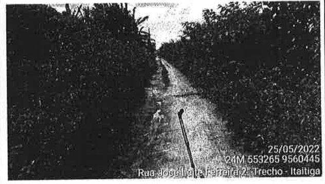
Vista geral do trecho e área a ser limpa
