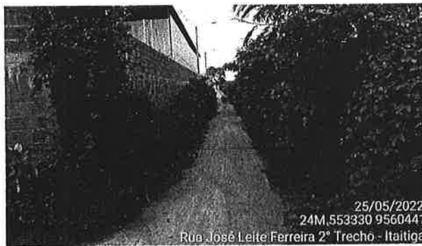
Vista geral do trecho
