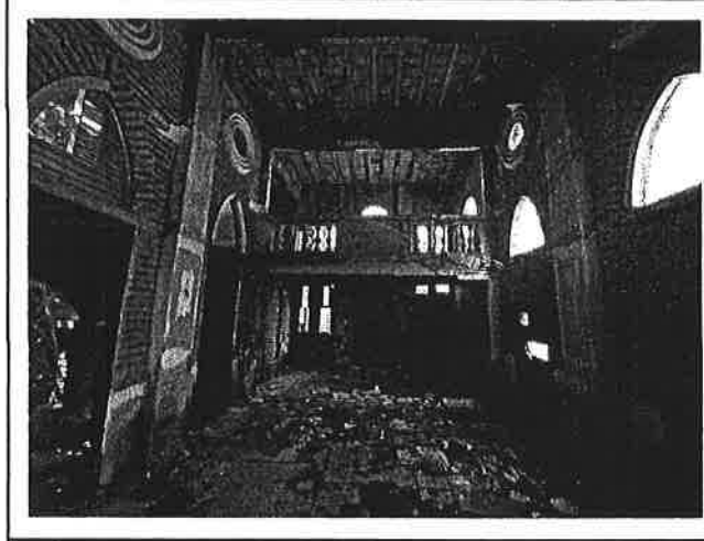
Área interna - Térreo
