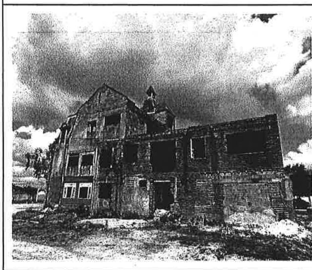
Fachada lateral - Direita
