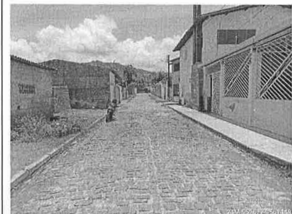
Visão geral da Rua Adailton Távora
