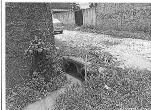
Visão do bueiro na rua João Assunção Cavalcante
