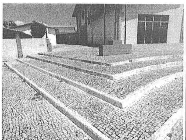
Detalhe escada de acesso à igreja
