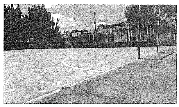
Parte interna da quadra
