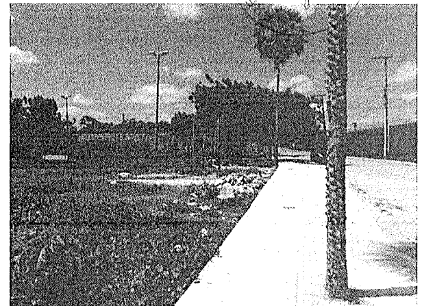
Calçada a ser demolida
