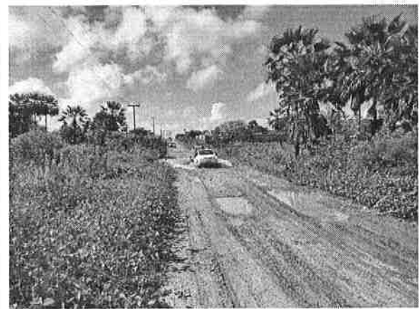
Passagem molhada- Avenida B
