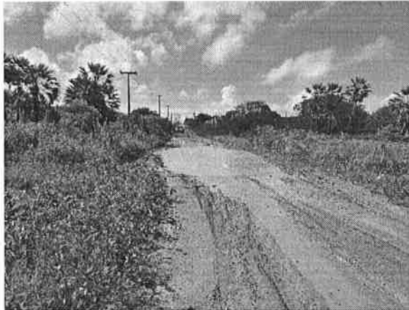
Passagem molhada- Avenida B
