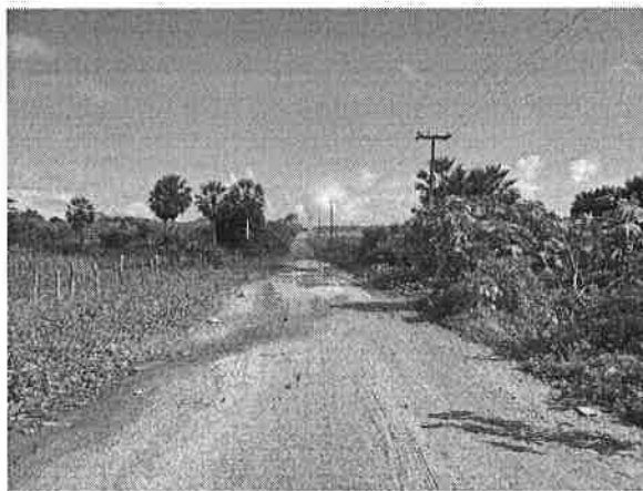
Passagem molhada- Avenida B
