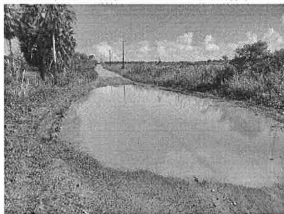
Passagem molhada- Avenida B
